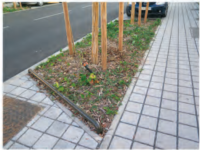
Ci-dessus : Exemple de travaux de désimperméabilisation
