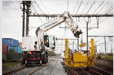
Opération de renouvellement de rails
